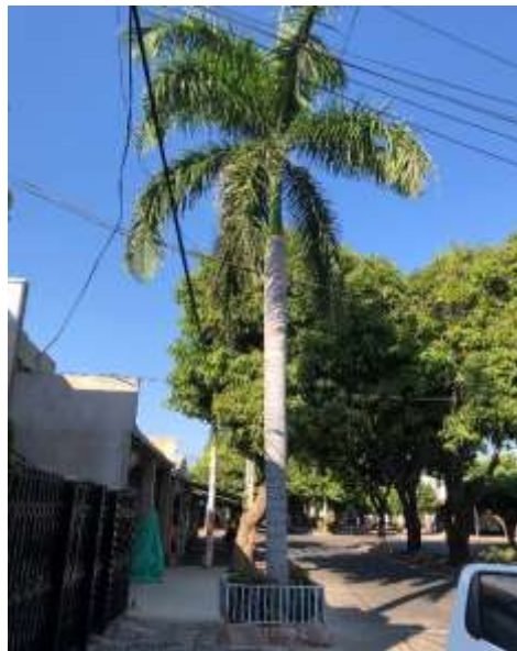
Fig No 2. Hace contacto con líneas telefónicas y eléctricas.
