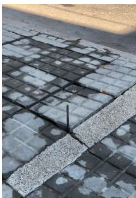
Fig No 5. Levantamiento del piso.
