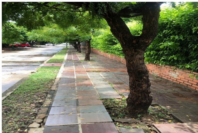
Árboles Para intervenir con poda de la especie Neem ( Azadirachta indica ), Ubicado en la Transversal 8No 2c -174 barrio los campanos de Valledupar- Cesar.
