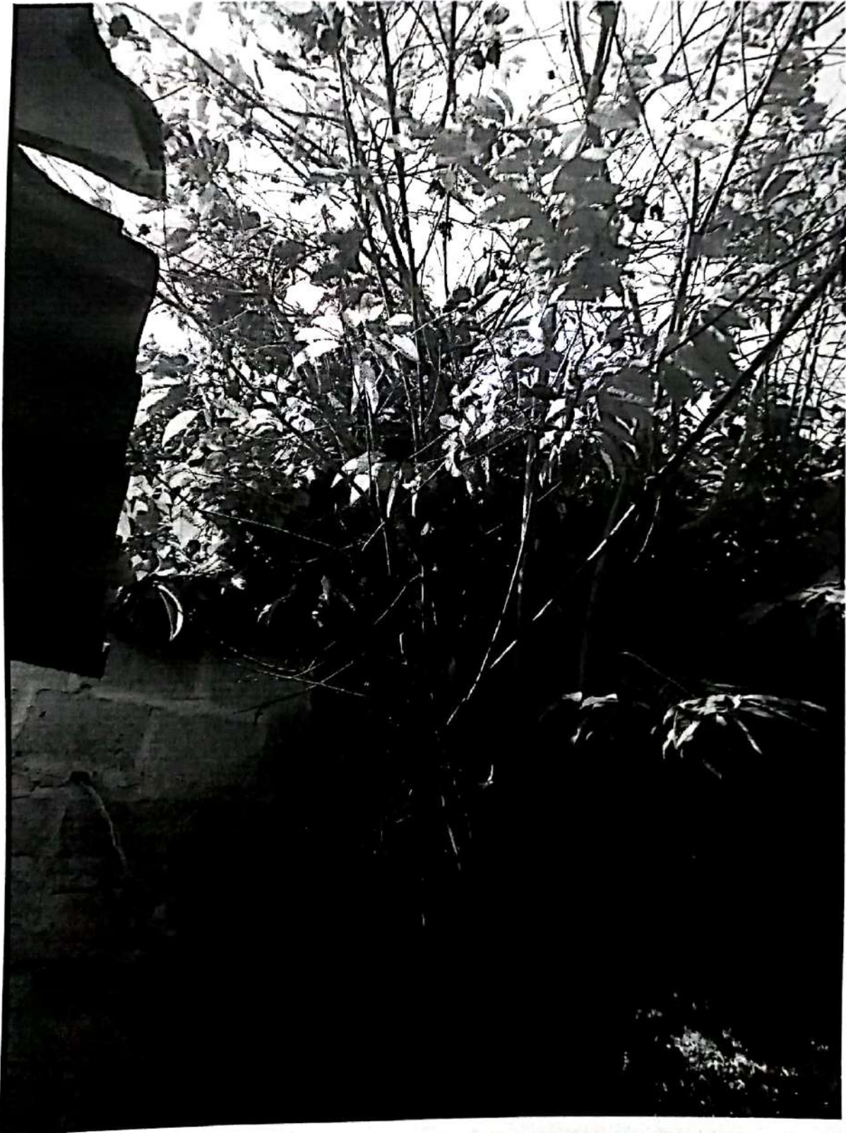
Imagen 2. Árbol con riesgo de causar daños mecánicos y eléctricos
