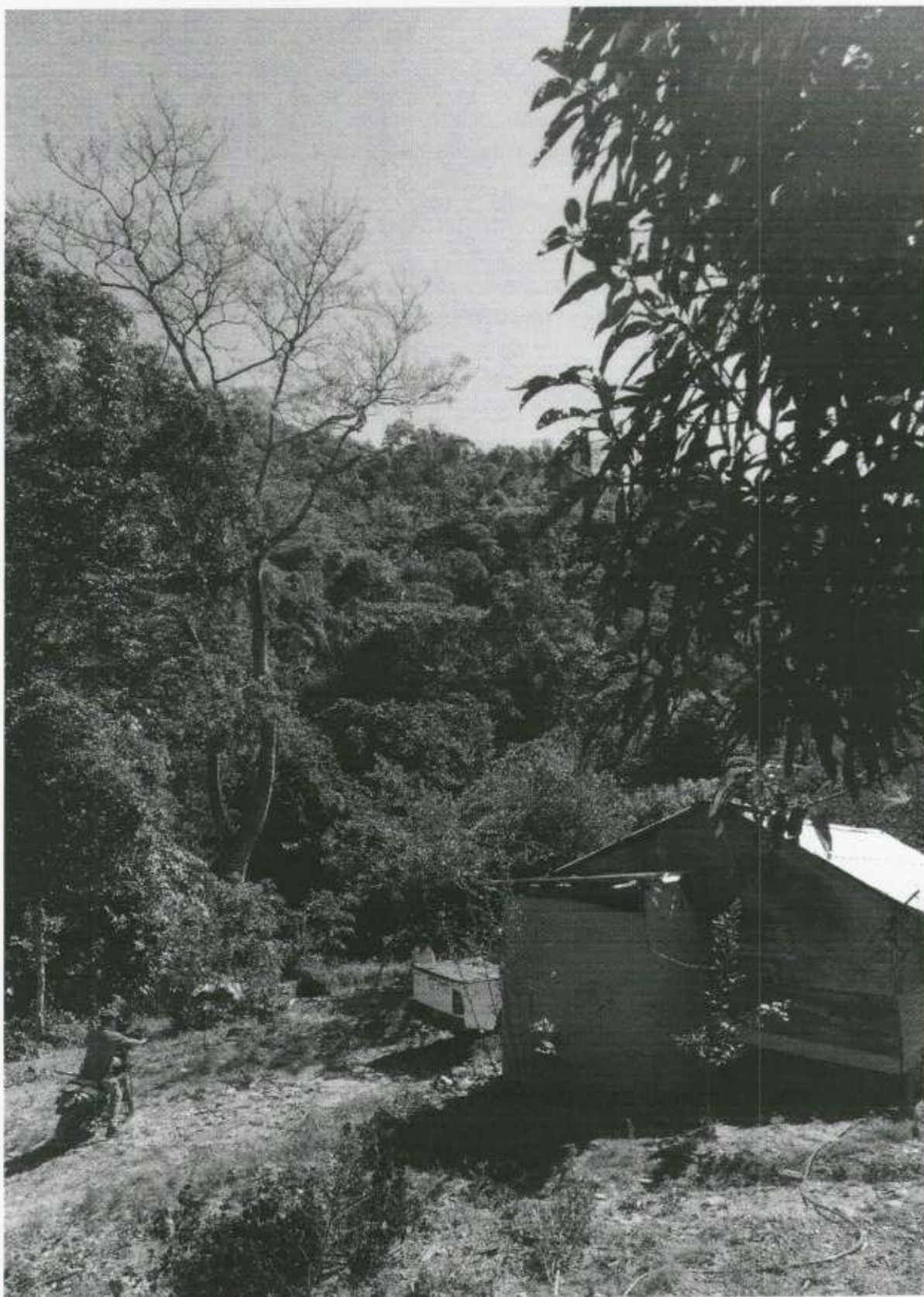
Imagen 3. Árbol con riesgo de causar daños mecánicos a vivienda
