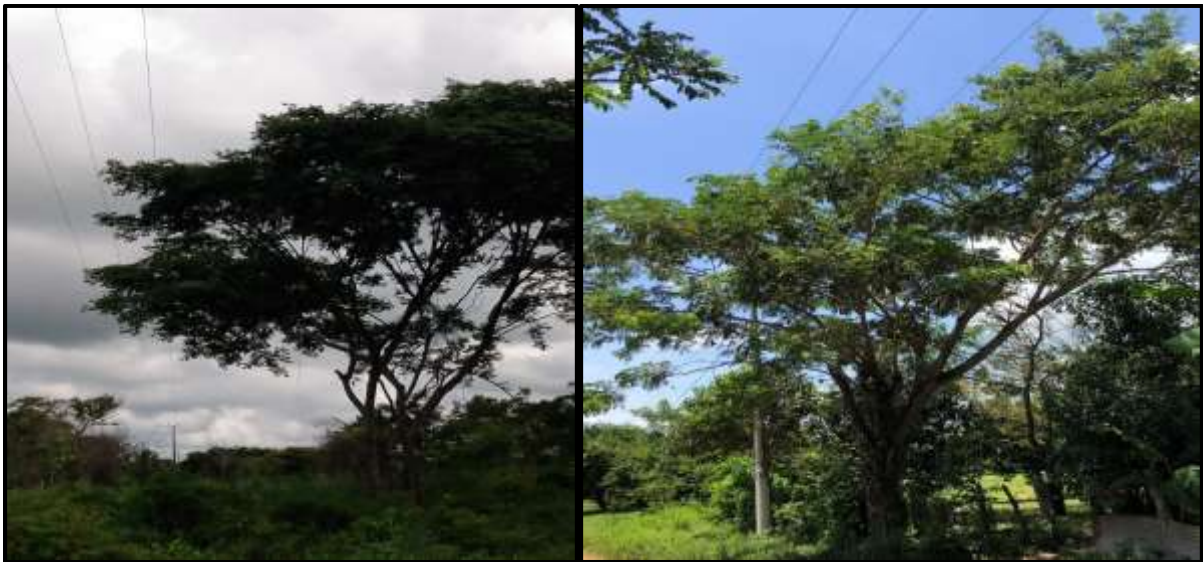
Imagen 91 y 92. de los árboles muestran la amenaza de entrelazarse las ramas con las redes eléctricas de media tensión, Recorrido kmz - tracks, zona rural de Chimichagua.
