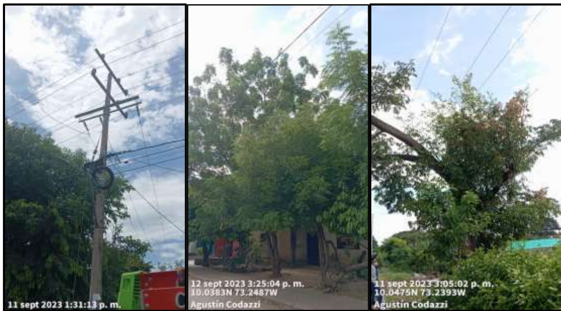
Imágenes 17 y 18 y 19. de los árboles muestran la amenaza de entrelazarse las ramas con las redes eléctricas de baja y media tensión Recorrido kmz - tracks, zona urbana Agustín Codazzi
