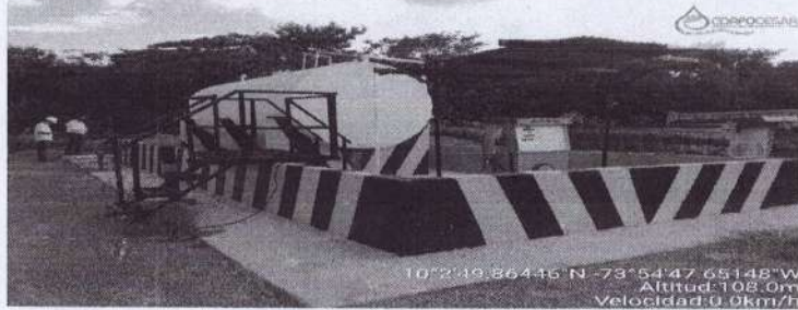
Imagen 3. Vista general de la infraestructura de almacenamiento de hidrocarburos (Biodiesel).
