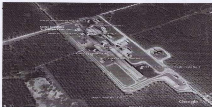
Imagen 4. Vista general, área del polígono del proyecto e infraestructuras principales asociadas Fuente: Google Earth Pro – Corpocesar
