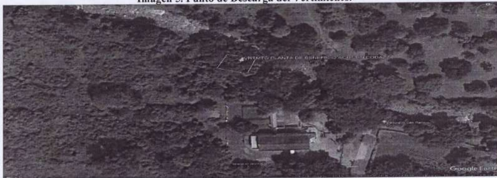
Imagen 5. Punto de Descarga del Vertimiento.
