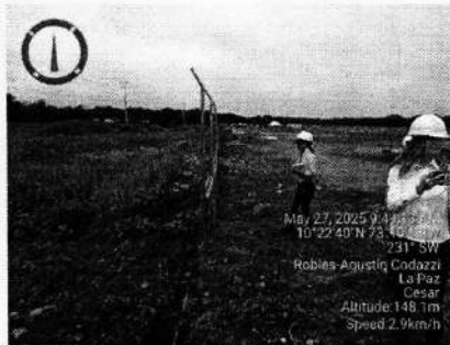
Foto 1. Inicio del muro vallado y canal perimetral.
