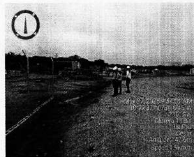
Foto 2. El canal se ubica al interior del muro y vallado perimetral oriental
