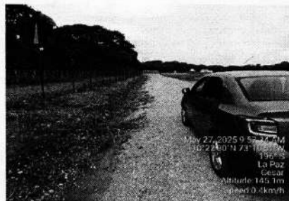
Foto 3. El canal se ubica al interior del muro y vallado perimetral oriental
