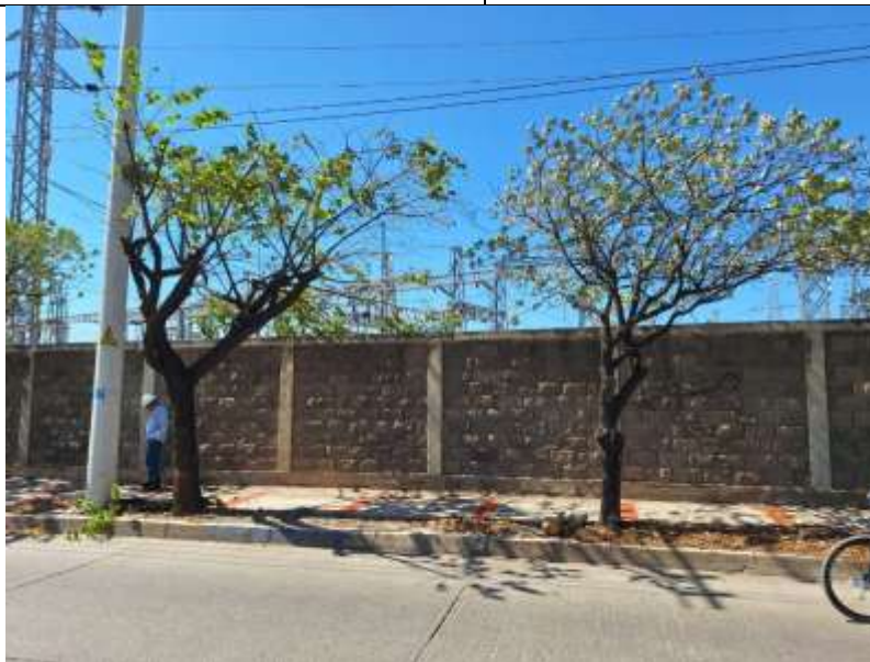
Foto 5. Ubicación de los arboles en relación a la paredilla, zona externa de la subestación, donde se prevee abrir el acceso.
