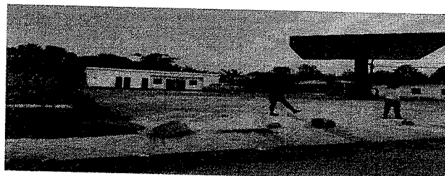
Imagen 1. Vista general Estación de Combustible Las Flores Fuente Corpocesar 2019
